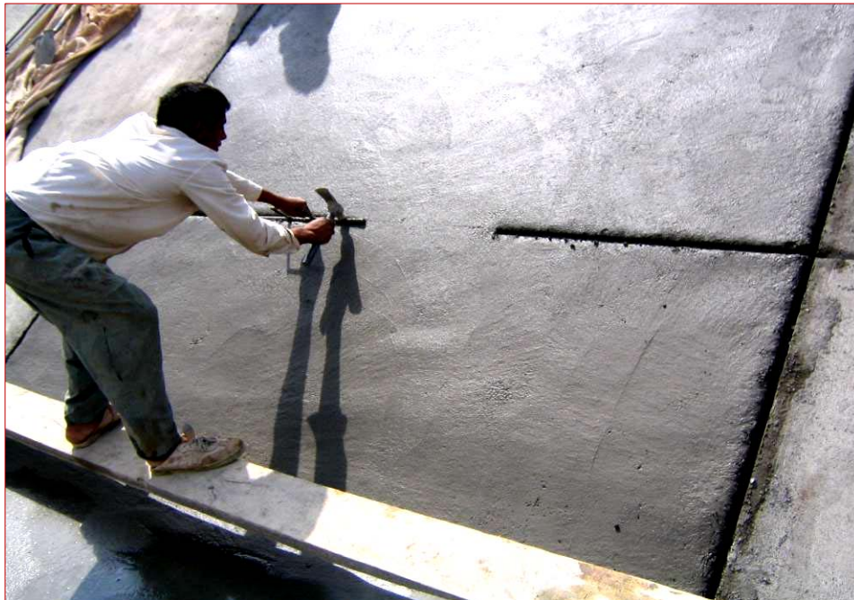
اجرای درزهای طولی و عرضی بصورت دستی
